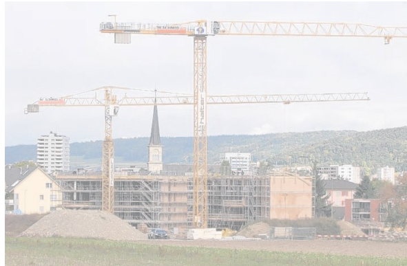
Am Dorfeingang von Neuenhof wird emsig gebaut.
