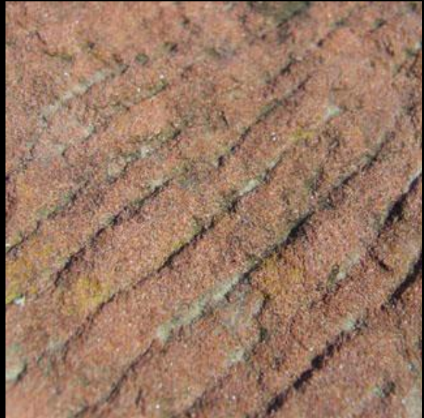
Sandstein in Bahnen gespitzt
