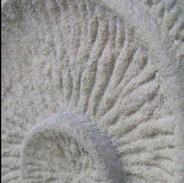
Sandstein, in Bahnen gespitzt
