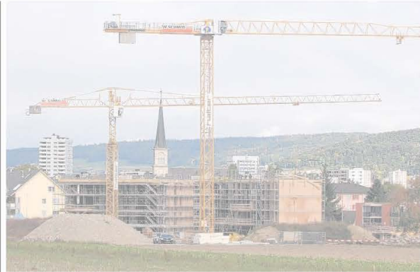
Am Dorfeingang von Neuenhof wird emsig gebaut.
